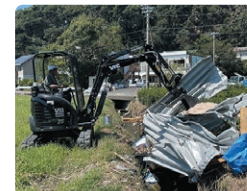
台風15号に伴う竜巻被害の被災地 静岡県牧之原市で使用されたVTC重機
